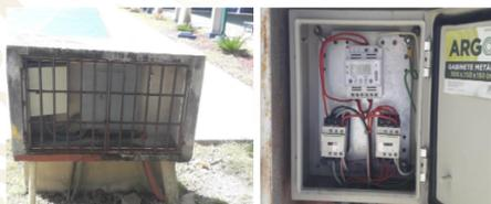
Timer instalado en Cancha de Básquetbol para controlar iluminación por días y horario.
