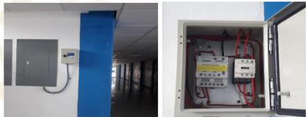
Timer instalado en edificio EAD para controlar iluminación de pasillo planta baja y alta.
